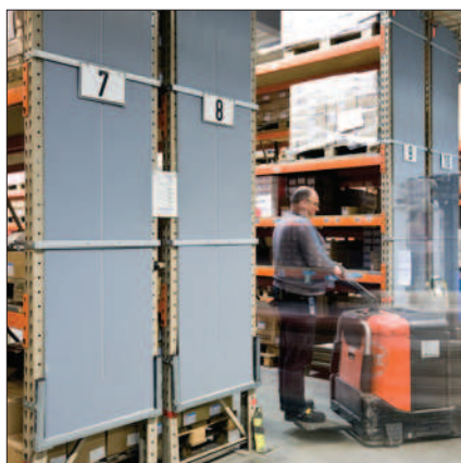
Emissione di calore a bassa temperatura in corrispondenza della postazione di lavoro
