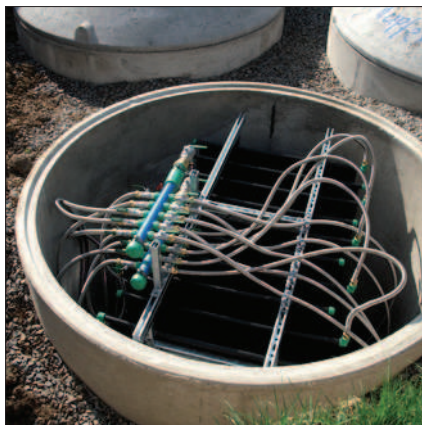
Utilizzo come scambiatore di calore in serbatoi; anche in serbatoi con ghiaccio
