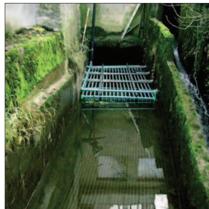
Utilizzo come scambiatore di calore in un canale d'acqua
