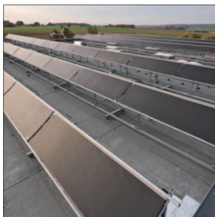
Installazione in copertura
