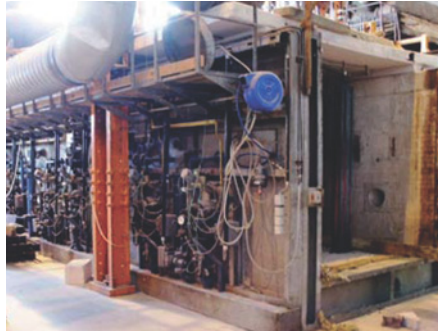
Fig. 1: Forno speciale per la prova incendio (proprietà - MPA)
