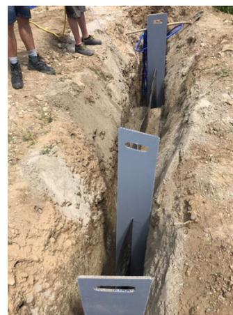
Installazione dello Scambiatore tramite gli appositi ausili sopra al telo bentonitico
